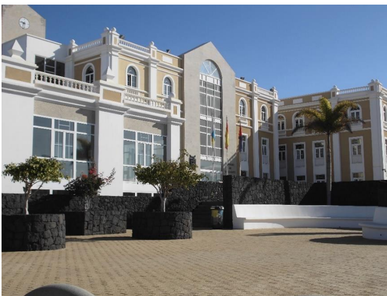
Figura 11 – Edifícios do Cabildo de Lanzarote. Fonte: OPExCATer
